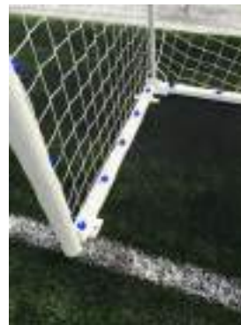
Ganchos de sujeción red y pletinas de amarre al suelo.
